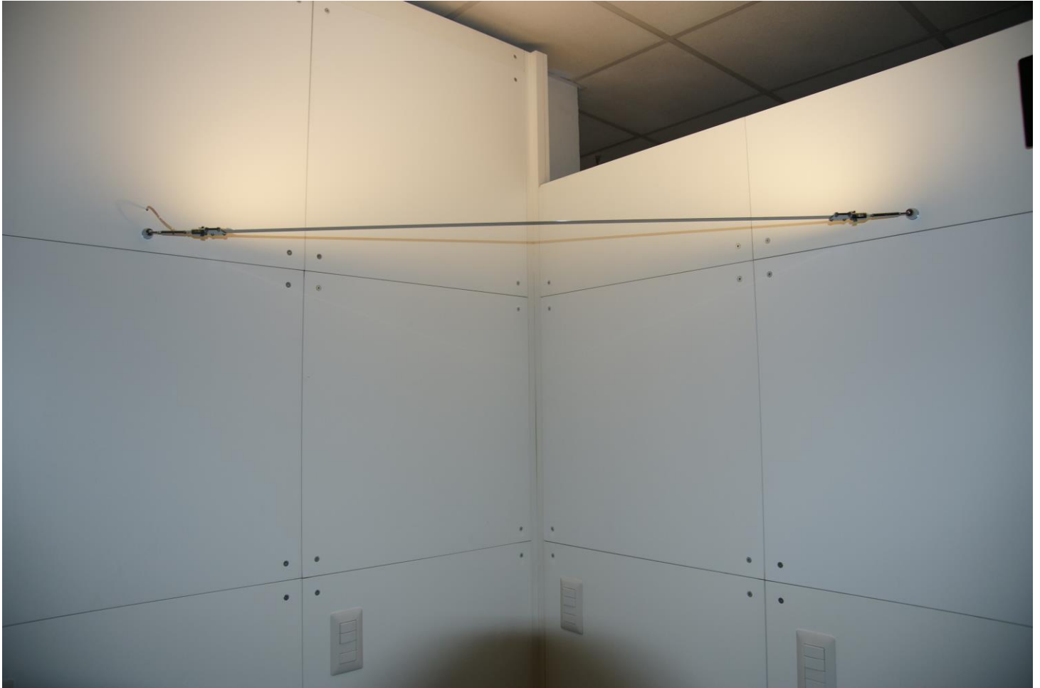
Sàrtia installata su parete ad angolo
